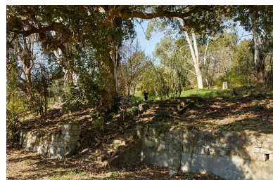
Escalier de desserte intérieure. Phot. Françoise Baussan IVR93_20210601687NUC2A
