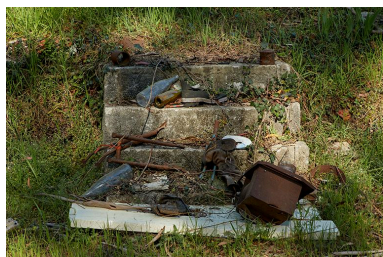
Escalier de desserte intérieure. Phot. Françoise Baussan IVR93_20210601685NUC2A
