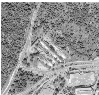
[Le hameau de Valbonne en juillet 1988 : 8 bâtiments subsistent. (vue aérienne).] Repro. Nathalie Van Bost, Phot. Institut national de l'information géographique et forestière (IGN) IVR93_20210600814NUC1A
