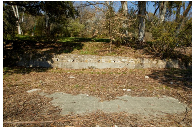
Vue générale du site : vestige d'une plate-forme. Phot. Françoise Baussan IVR93_20210601688NUC2A
